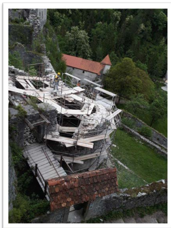
Slika: Vzdrževalna dela na Gradu Kamen
