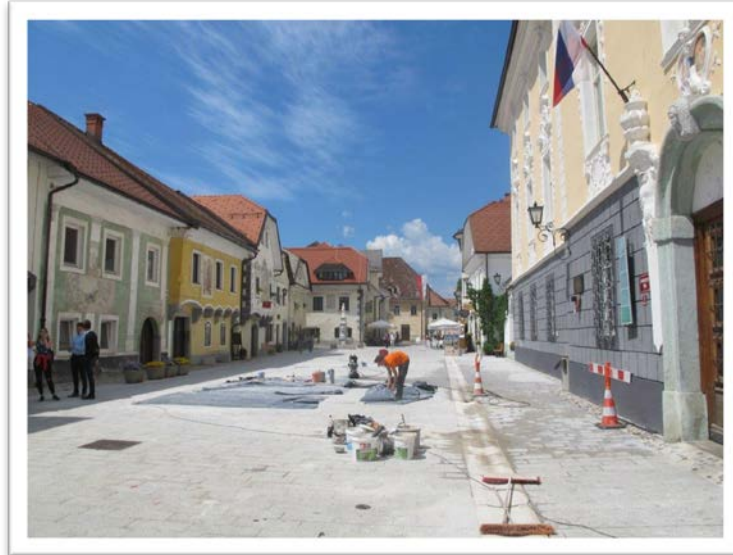
Slika: Sanacija poškodovanega tlaka na Linhartovem trgu
